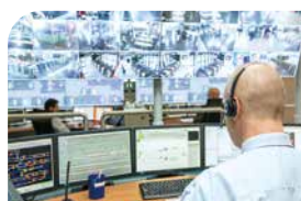
監視システム
